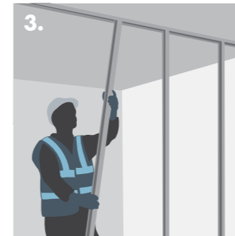
3. Twisting Knauf 'C' Stud into position.
