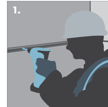
1. Fixing Knauf Perimeter Channel.
