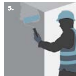
5. Applying Knauf Wallboard Primer.
