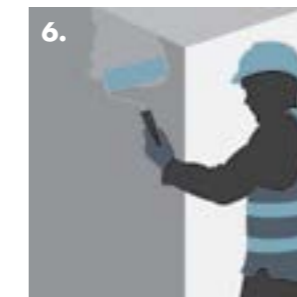
6. Applying Knauf Wallboard Primer.
