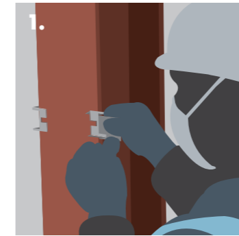
1. Installing Knauf Fixing Clips.
